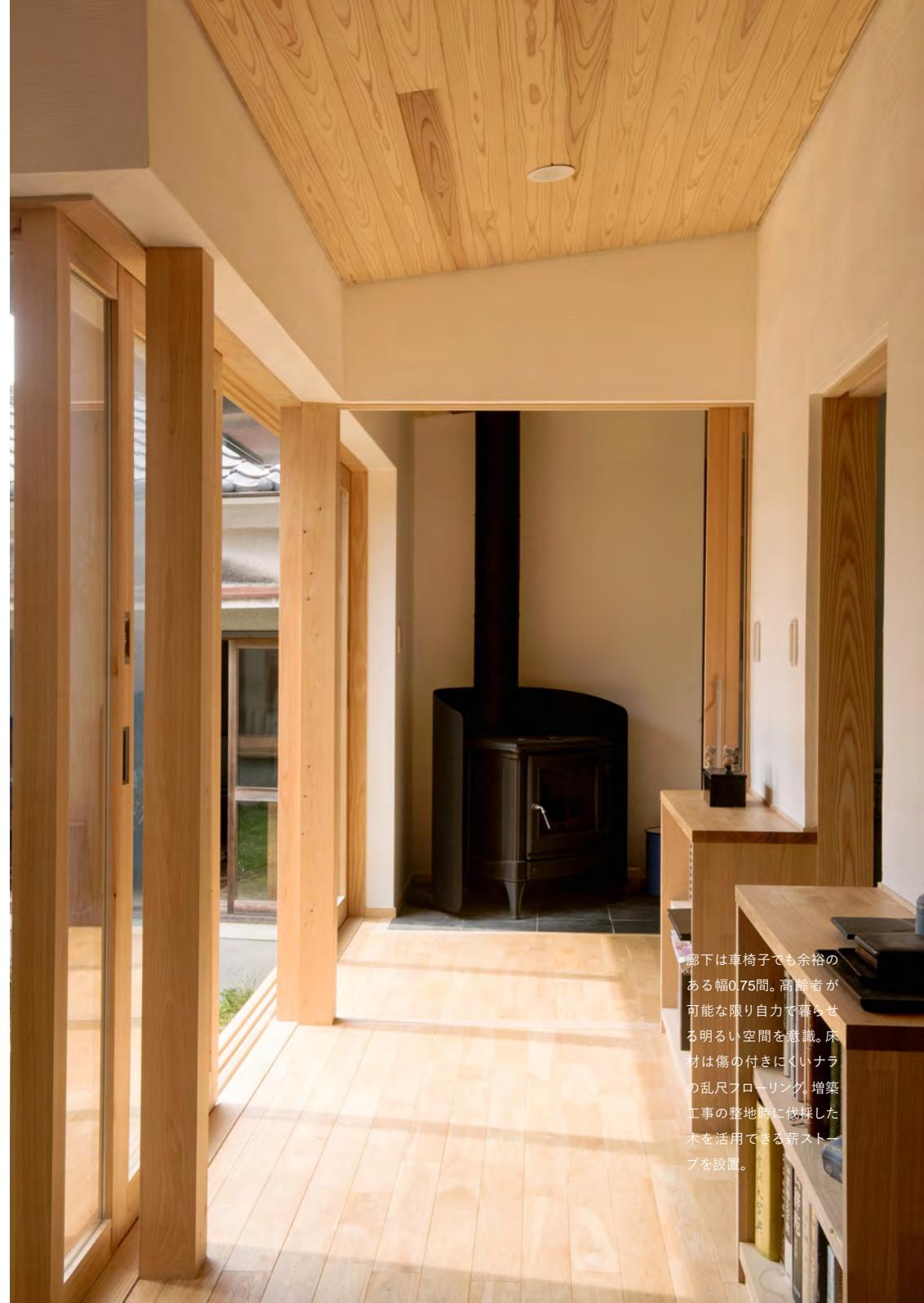
廊下は車椅子でも余裕のある幅0.75間。高齢者が可能な限り自力で暮らせる明るい空間を意識。床材は傷の付きにくいナラの乱尺フローリング。増築工事の整地時に採集した木を活用できる薪ストーブを設置。
