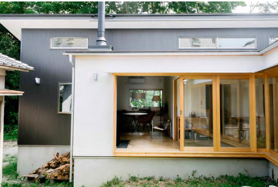
「平成の増築棟」は、左手に見える「昭和の増築棟」と、プロポーションやスケールを合わせている。開放感と風通しを確保するため引き違いの建具で大開口とした。室内と素材感をそろえた木製建具に、複層ガラスを入れている。
