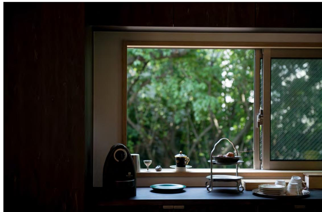
敷地内の木々に向けたキッチンの窓。両側に耐力壁を設置。外周部の窓は規格品で、上端の高さを揃えている。
